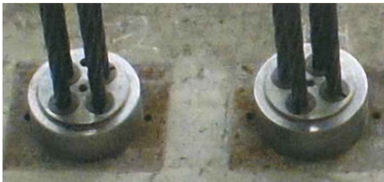
Установка обоймы анкера
