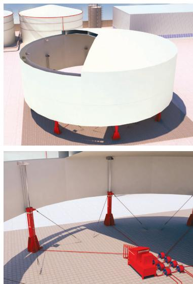
■ Разработана для строительства на месте монтажа методом «подрашивания» изотермического резервуара, хранилища сжиженного этилена, диаметром 28 м, объемом 10 000м3.
