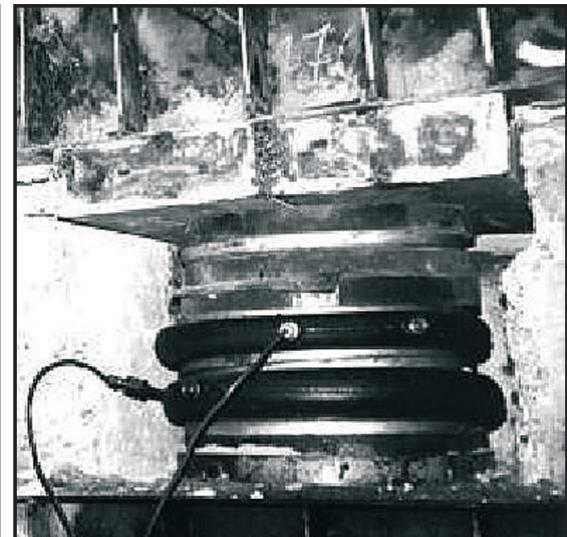
■ За рубежом активно используют гидравлические домкратные системы для корректировки геометрического положения зданий и сооружений, с целью компенсации деформаций вследствие просадки грунта.
