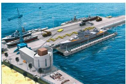
■ Система позволяет осуществлять подъем и опускание подводных лодок, кораблей и других морских транспортных средств с суши на воду или с воды на сушу.
