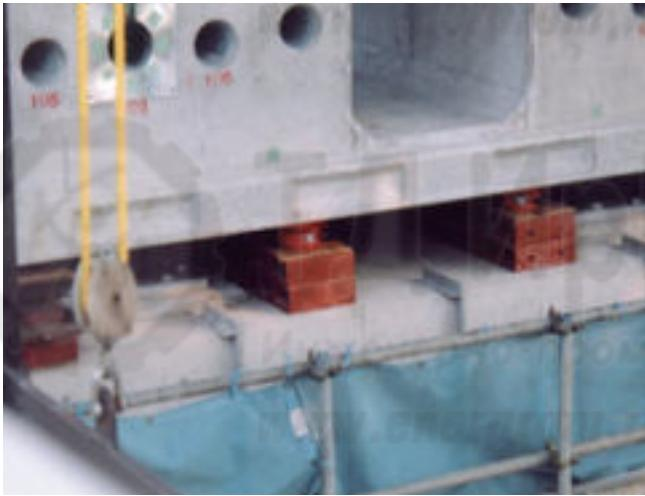
Низкий домкрат JFN200S3 с фиксирующей гайкой
