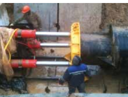
Установка для бестраншейной прокладки труб серии УБПТ «Горизонт» на особо важном государственном правительственном объекте «Трубопроводная система «Восточная Сибирь – Тихий Океан».
