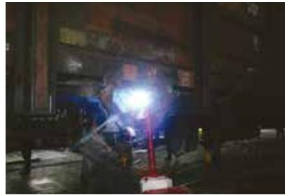
Поджатие дефектного места и проведение сварочных работ
